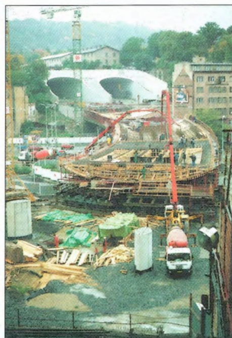
Obr. 6 – Betonáž hlavního mostu / Casting of the main bridge
