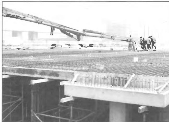
Obr. 6 – Použitie priznaných prefabrikovaných hlavíc spriahnutých s monolitickou doskou pri prenose veľkých zaťažení / Use of precast heads composed with monolithic slab, designed for heavy loads
