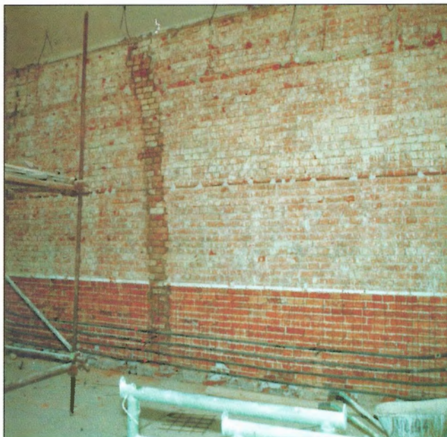
Obr. 6 – Pohled na střední část zesilované zděné stěny / View on the middle part of strengthened masonry wall
