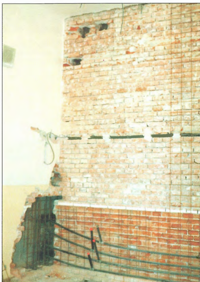
Obr. 7 – Pevné kotvy ve štítu / Rigid anchors in gable wall
