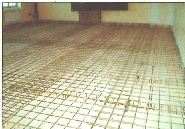
Obr. 5 – Zesílení stropní konstrukce před provedením betonové desky / Strengthening of floor structure before concrete casting
