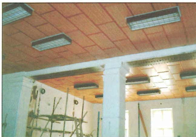
Obr. 3 – Pohled na nýtovaný nosník před rekonstrukcí / Rivet beam view, before reconstruction
