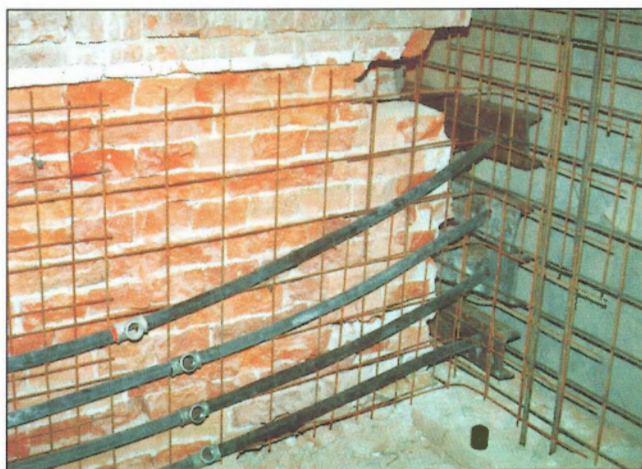
Obr. 10 – Detail kotevních oblastí u pevných kotev (pohled z druhého líce) / Detailed view from back face of the wall on the anchorage
