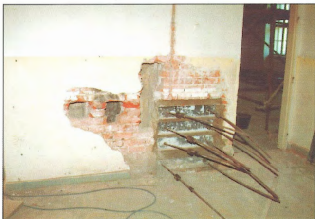
Obr. 9 – Pohled na kotvy před realizací předepnutí / Anchors before prestressing (view)
