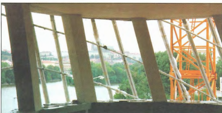
Obr. 10 – Hotové vnitřní sloupy „Ginger“ / Completed internal “Ginger’s” columns
