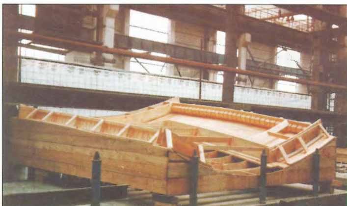
Obr. 8 – Forma na stěnový prefabrikát / Formwork for a wall element
