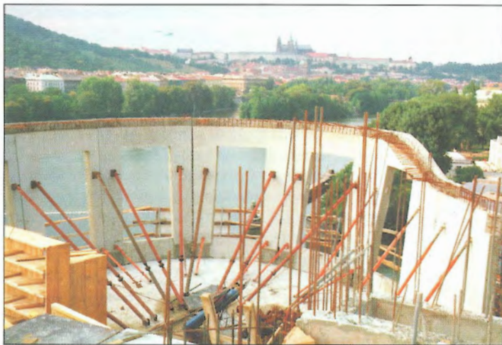
Obr. 7 – Poslední řada stěnových prvků / The last level of wall elements
