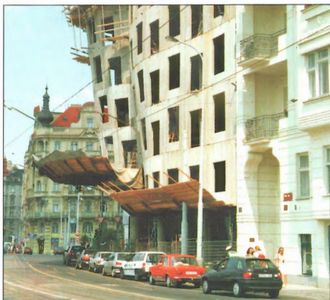
Obr. 16 – Pomocná lešení během montáže / Temporary scaffolding during assembly
