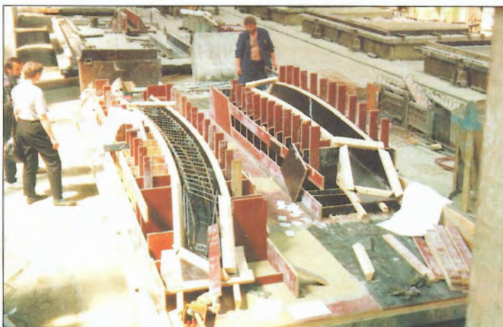
Obr. 9 – Balkonové podpory / Balcony supports
