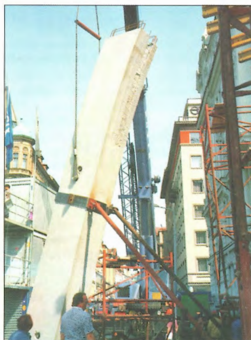
Obr. 12 – Montáž sloupu / Column assembly
