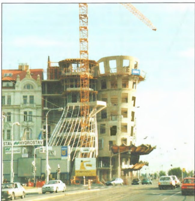
Obr. 17 – Konstrukce věží / Tower structure
