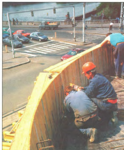
Obr. 11 – Bednění podstavy věže „Fred“ / Formwork of the “Fred” tower bottom slab
