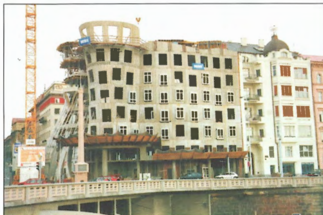
Obr. 14 – Nosná konstrukce před dokončením / Structure before completion
