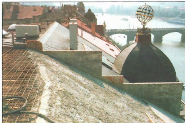
Obr. 15 – Betonáž střechy / Concreting the roof
