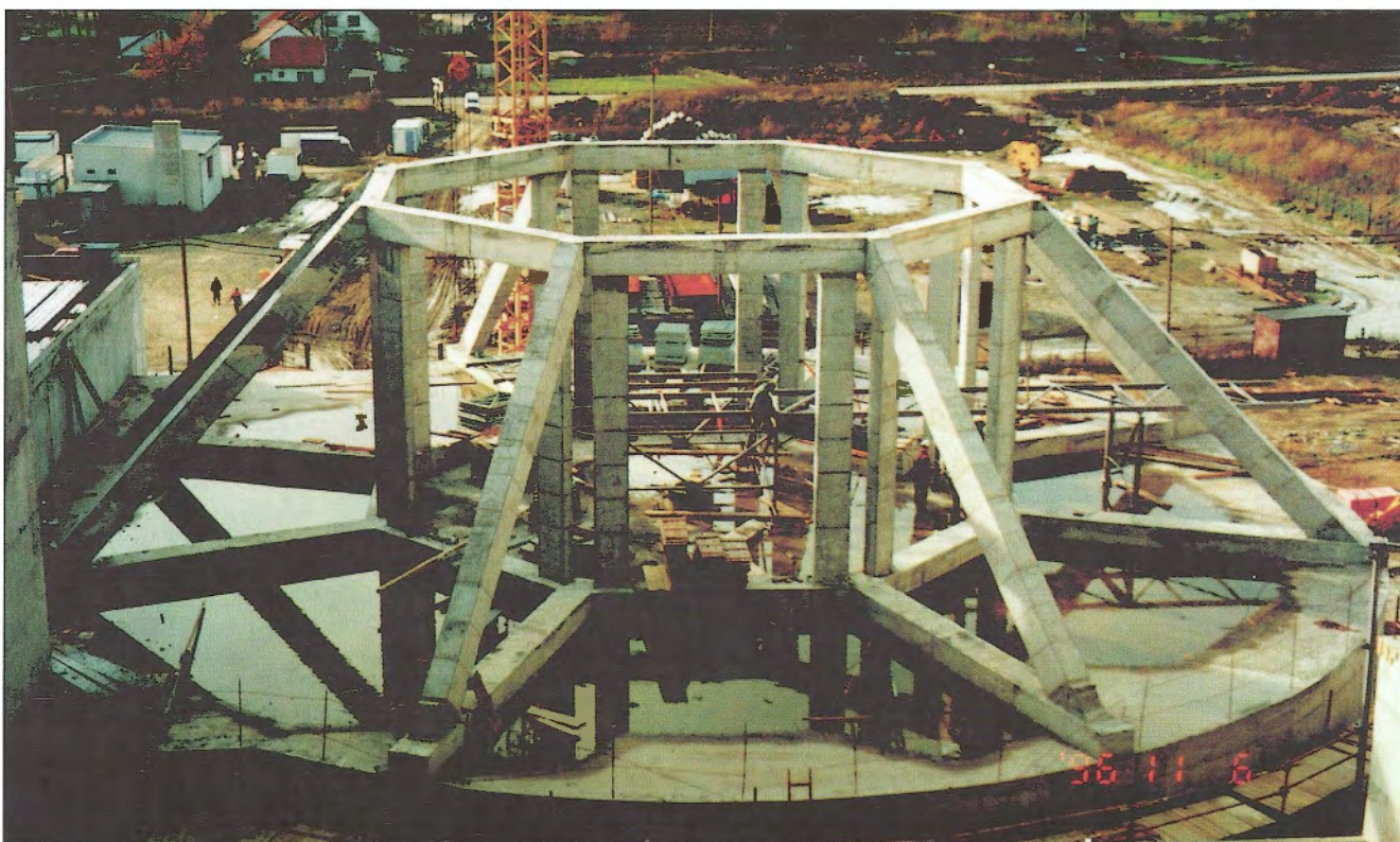
Obr. 2 – Celkový pohled na prostorové věšadlo / General view on spatial hanger
