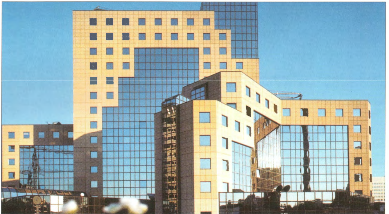
Obr. 2 – Administrativní budova ve Frankfurtu n/Mohanem s povrchově upravenými betonovými fasádními dílci v soustavě dutinového pláště. Barvená zavěšená porfyrová fasáda s vnitřním větráním kombinovaná s kovovými a skleněnými plochami – viz referáty sekce 4 (přetištěno s laskavým svolením fy IMBAU, D-63262 Neu-Isenburg)
