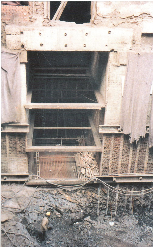
Obr. 4 – Pohled do prostoru výtahu / Elevator area view
