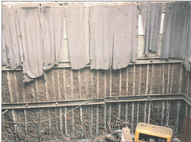
Obr. 5 – Pohled na severní stěnu jámy / North side view
