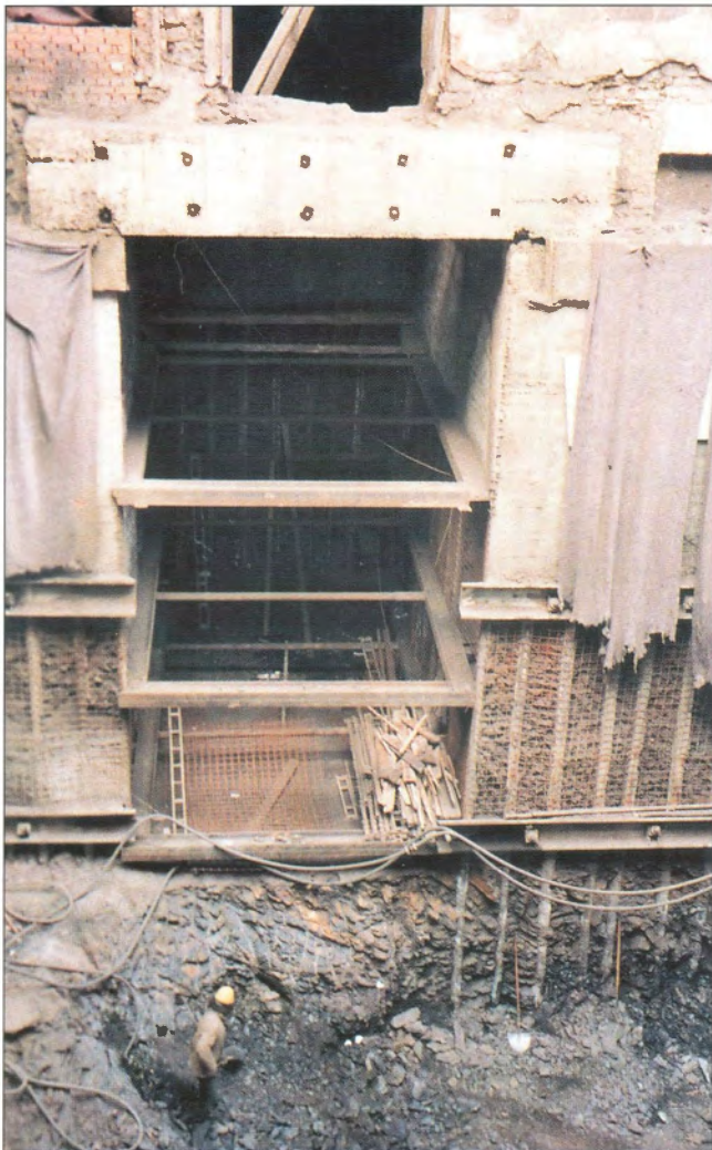
Obr. 4 – Pohled do prostoru výtahu / Elevator area view
