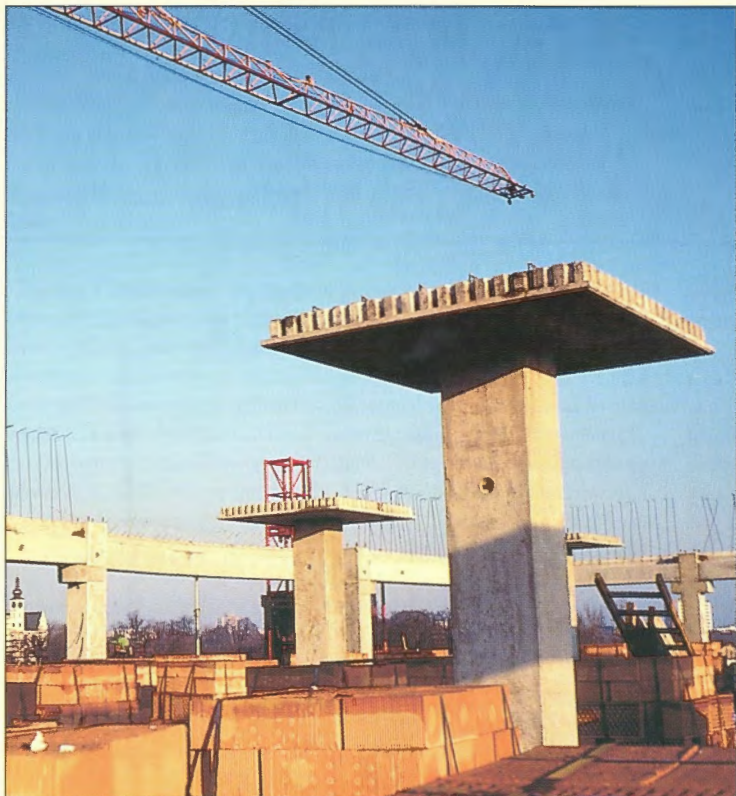
Stropní konstrukce po odbednění / Floor structure after formwork strip
