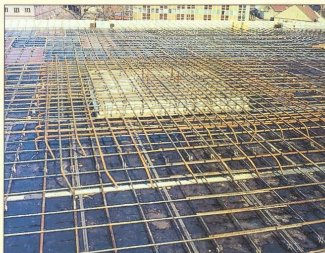
Stropní deska s hlavicí a výztuží připravena k betonování / Flat-slab with head and reinforcement prepared for casting
