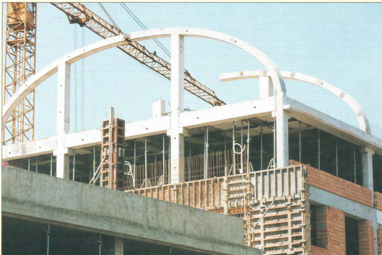
Prefabrikované obvody a ramenáty střešní konstrukce / Precast edge beams and roof structure
