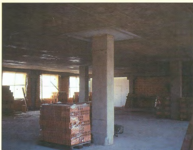
Prefabrikované sloupy a hlavice při výstavbě / Precast columns and heads during construction
