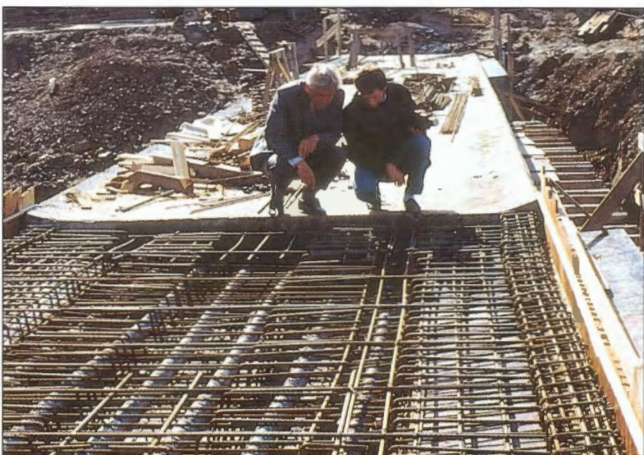
Obr. 8 – Výztuž nad kyvnou stojkou / Reinforcement above the pendulum stanchion
