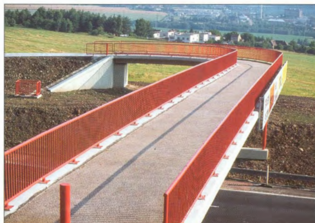
Obr. 11 – Dokončené vybavení lávky / Completed footbridge
