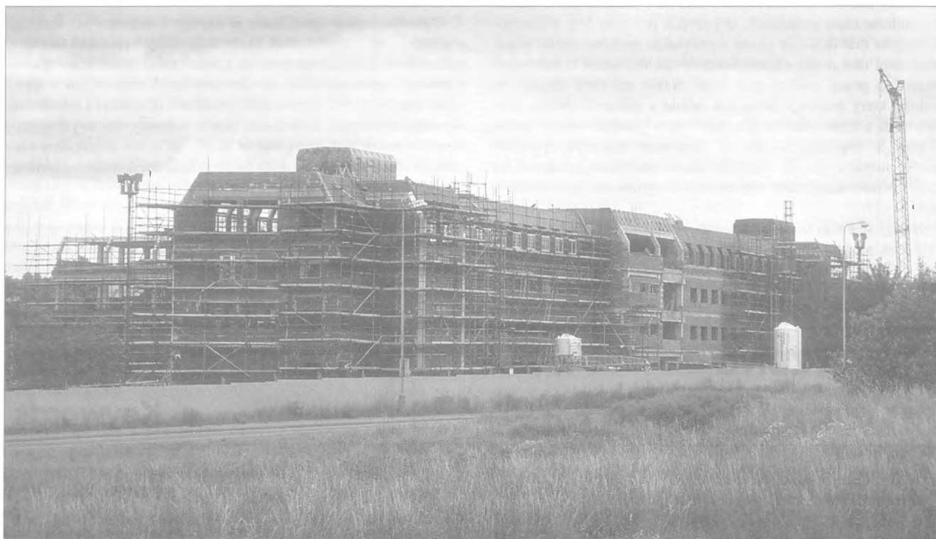
Obr. 1 – Z realizace výstavby gymnázia v Sokolově s použitím tvárnic Liapor / Construction of a building built of the Liapor blocks
