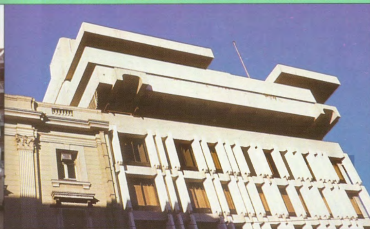
Athény (Athens) – Balkony nadstandartních bytů v horních podlažích budovy v centru města, tvořící zároveň zvukovou bariéru před hlukem z ulice / Balconies of de-luxe flats on upper floor of a building in the City of Athens, providing sound protection
