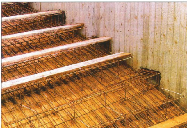
Obr. 6 – Detail výztuže hlavního schodiště / Reinforcement of the main staircase
