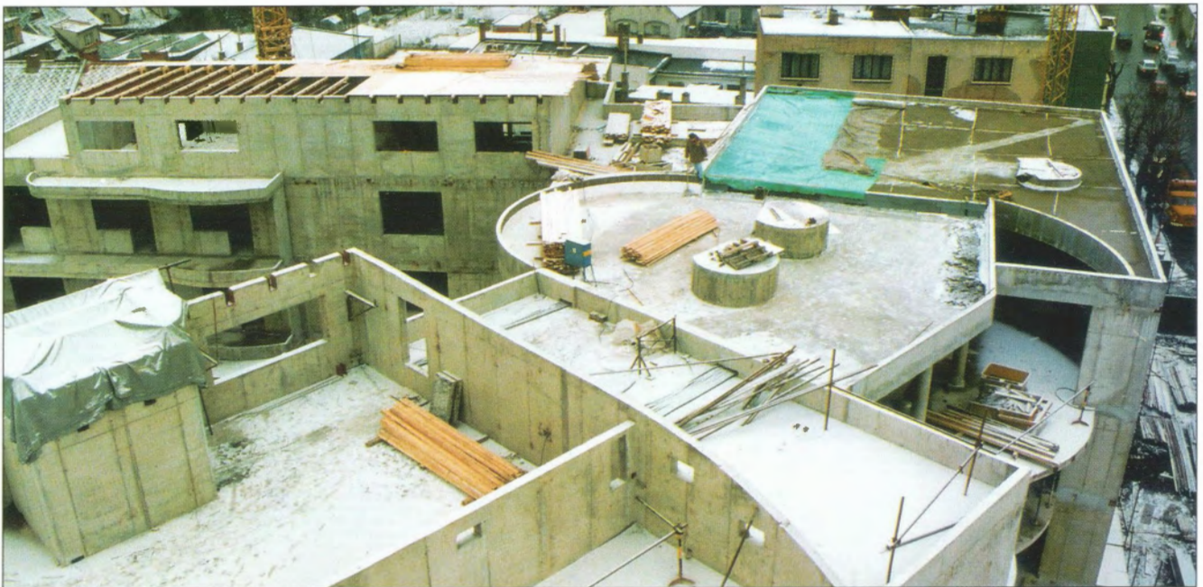
Obr. 10 – Pohled na dokončenou nosnou konstrukci / Bearing structure completed
