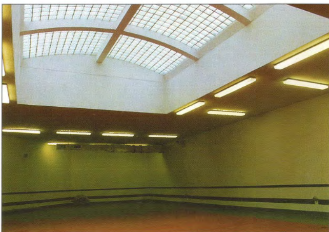
Obr. 8 – Sklobetonová část zastřešená / Glass brick roof
