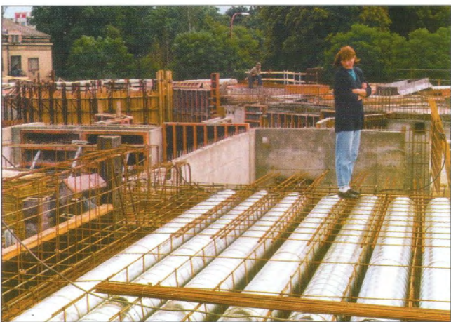
Obr. 7 – Vylehčená stropní konstrukce před betonáží / Cellular floor structure
