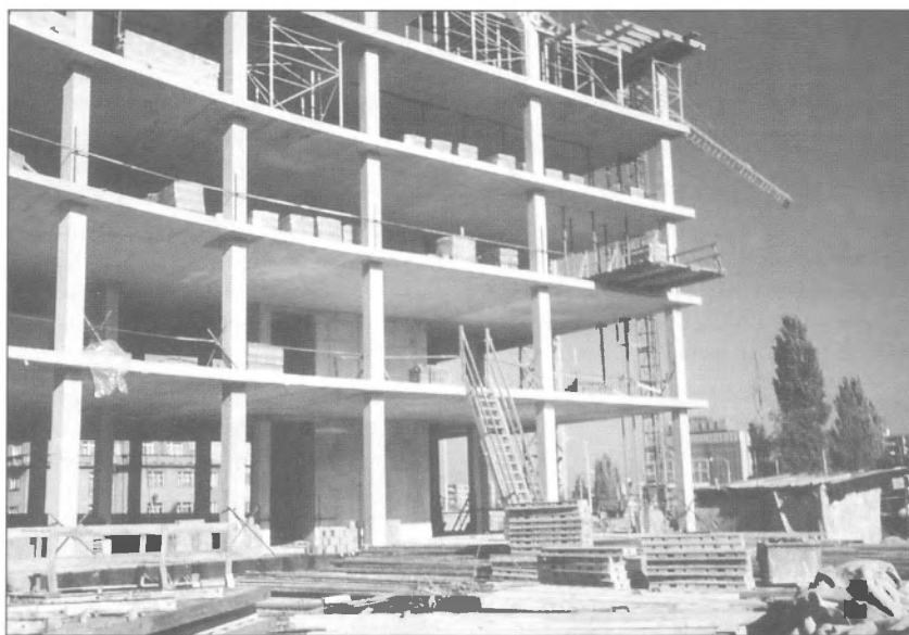
Obr. 4 – Pohled na část nedokončené konstrukce bezprůvlakového skeletu se schodištvým jádrem / View of the uncompleted part of the flat-slab car-casse structure with the staircase core
