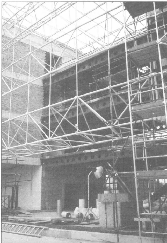
Obr. 5 – Pohled mezi rozestoupené části skeletu s vloženými ocelovými konstrukcemi ochozů, průčelní stěny a střechy vstupní haly / View between spaced parts of the carcasse with inserted steel structures of the galleries, front wall and roof of the entrance hall
