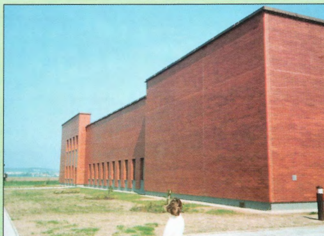
Obr. 6 – Továrna na výrobu léčiv Arrow, Hradec Králové / Pharmaceuticals factory Arrow, Hradec Králové, Bohemia
