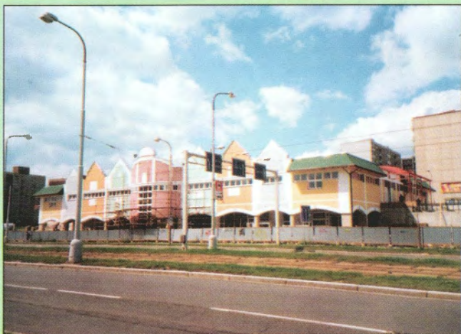
Obr. 10 – Nákupní středisko Plzeň-Lochotín / Shopping centre in Plzeň, Bohemia
