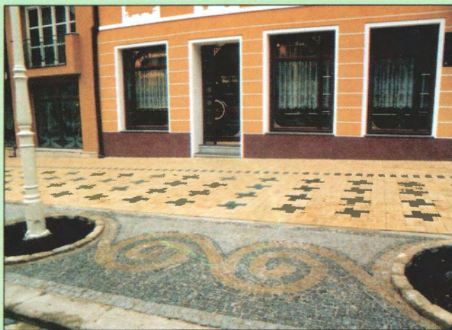
Obr. 8 – Komplexní rekonstrukce Národní třídy, Františkovy Lázně / Reconstruction of the National Street, Františkovy Lázně, Bohemia
