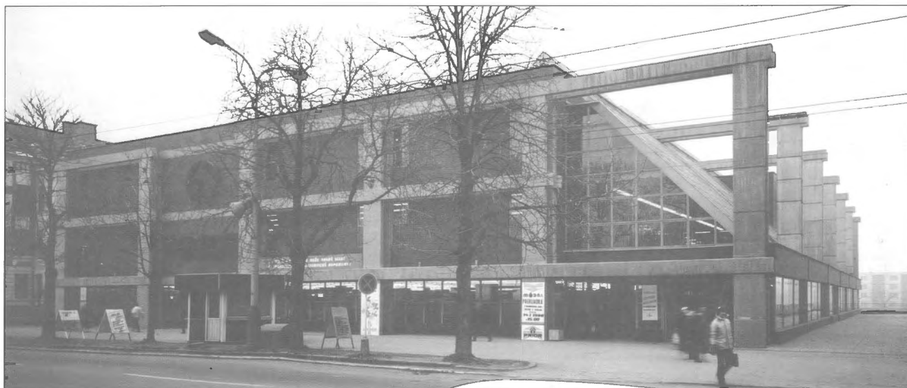
Obr. 4 – Obchodní dům Prior v Prešově s přiznanou tektonikou skeletu Integro / Warehouse PRIOR in Prešov with visible INREGRO system
