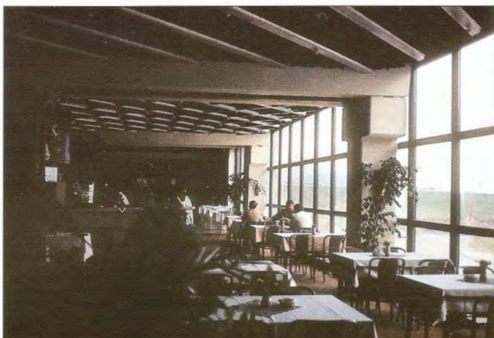
Přiznané konzoly skeletu Integro interiéru restaurace příměstského nákupního střediska v Bratislavě-Lamači / Corbels in interior of suburban Shopping Centre in Bratislava Lamači
