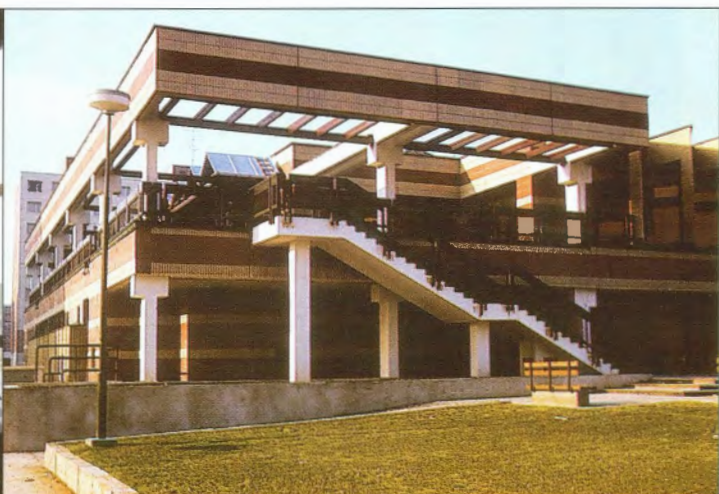
Nákupní středisko v Bratislavě - Petržalka s přiznanými konzolami skeletu Integro / Shopping Center in Bratislava with visible corbels of precast skeleton Integro
