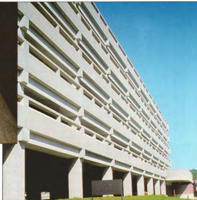
Vícepodlažní budova parkingu u jedné ze stanic metra v Bostonu s viditelnými konzolami obvodového betonového pláště a se skrytými konzolami nosné konstrukce / Multistorey Parking Center in Boston. Visible and hidden corbels of precast structure
