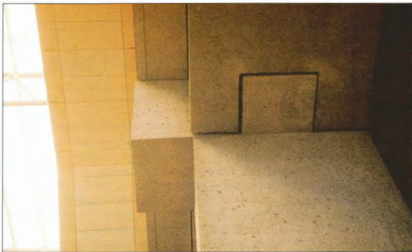
Vícepodlažní budova parkingu u jedné ze stanic metra v Bostonu s viditelnými konzolami obvodového betonového pláště a se skrytými konzolami nosné konstrukce / Multistorey Parking Center in Boston. Visible and hidden corbels of precast structure
