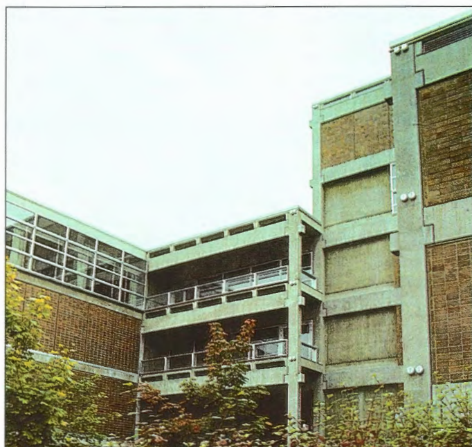
Hlavní objekt univerzity v Oslo s dominantním přiznáním krátkých konzol montované konstrukce / Building of University in Oslo. Visible corbels of precast structure as a component of architecture
