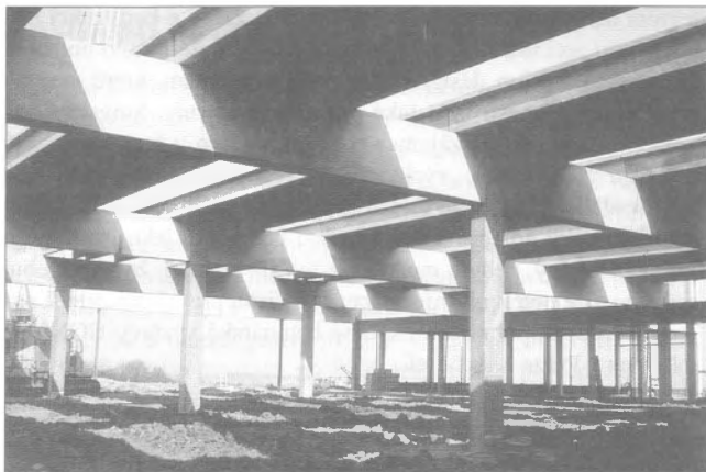
Obr. 6 – Skelet Premo při výstavbě obchodního střediska NICO v Říčanech u Prahy / System PREMO under construction of the department store Nico near Prague
