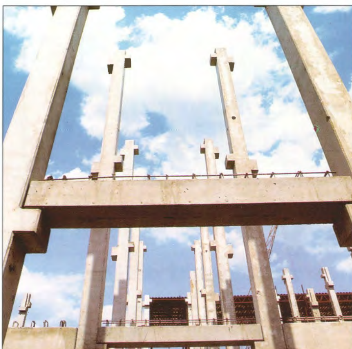
Sloupy s třemi úrovněmi konzol montované konstrukce chirurgického střediska SANUS v Hradci Králové / Columns with three levels of corbels. Pre-cast structure Premo of Surgeon Private Center SANUS in Hradec Králové
