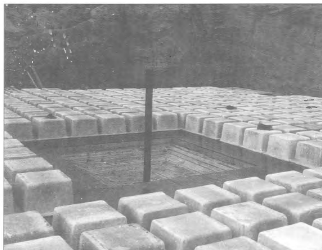
Obr. 1 – Bednění kazetového hřibového stropu s rozpony 12/12 m pro obchodní dům PRIOR v Nitre / Molding of mushroom waffle floor for warehouse in Nitra
