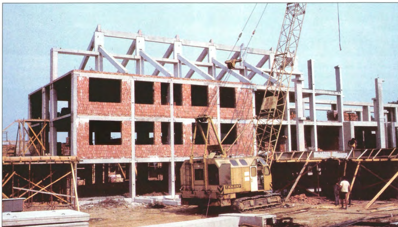
Obr. 5 - Skelet Premo při výstavbě ústavu sociální péče ve Chvalčově / System PREMO under construction in Chvalčov
