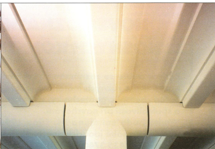
Montovaná administrativní budova v Berlíně, sloup s krátkými konzolami pro uložení tvarovaných nosníků na skládce ve výrobě Preming Chrudim v Opatovicích nad Labem a po jeho zabudování s přiznáním konstrukce v interiéru / Columns with corbels in Manufacturing Plant of Preming Chrudim in Opatovice and the same elements in interior of Office Building in Berlin
