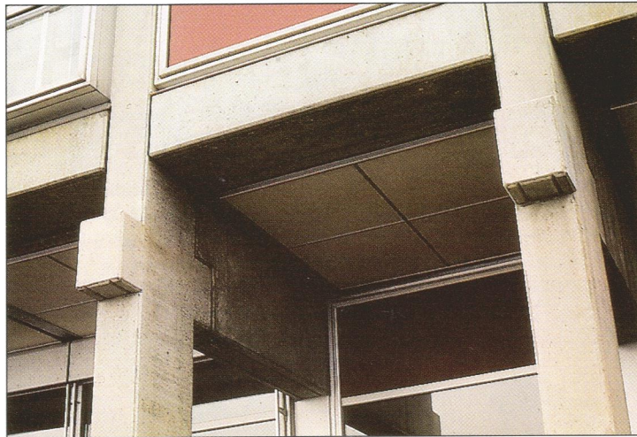
Hlavní objekt univerzity v Oslo s dominantním přiznáním krátkých konzol montované konstrukce / Building of University in Oslo. Visible corbels of precast structure as a component of architecture
