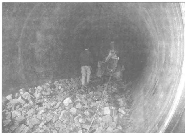
Obr. 2 – Rekonstrukce vyzdívký v rotační peci / Reconstruction of a rotary kiln refractory
