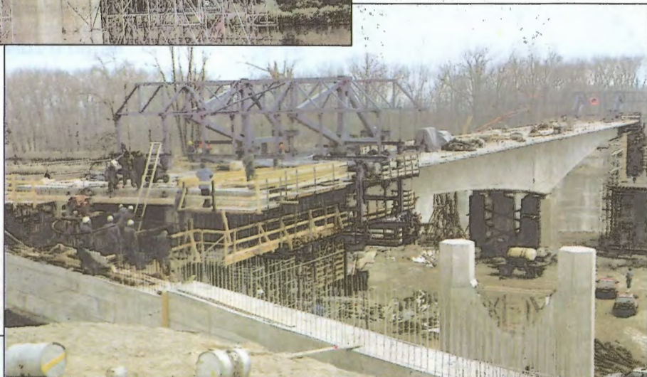
Obr. 13 – Zmonolitnění rampy a vahadla letmé betonáže
