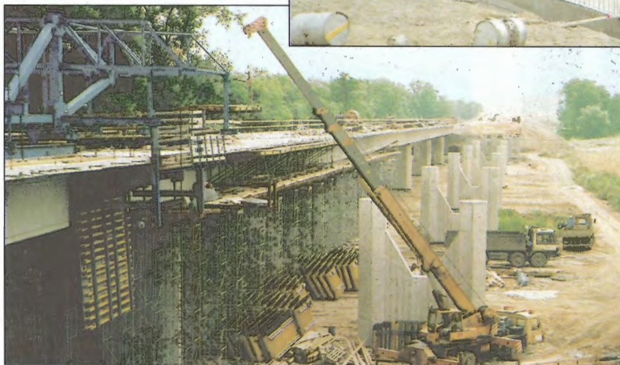
Obr. 14 – Dokončení nosné konstrukce povodního mostu
