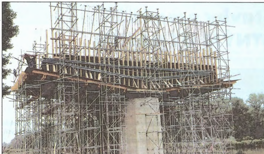
Obr. 12 – Dokončení vahadla letmé betonáže na ústecké opěře
