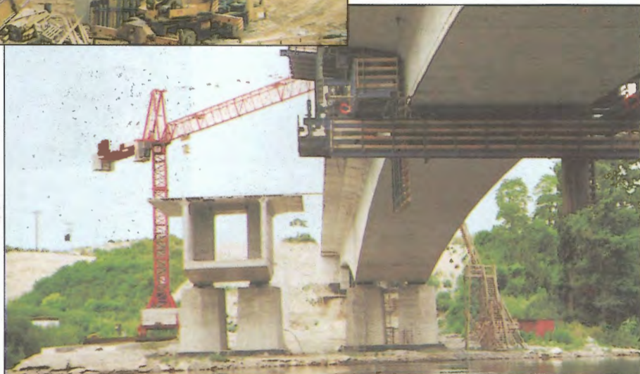
Obr. 14 – Dokončení nosné konstrukce povodního mostu
