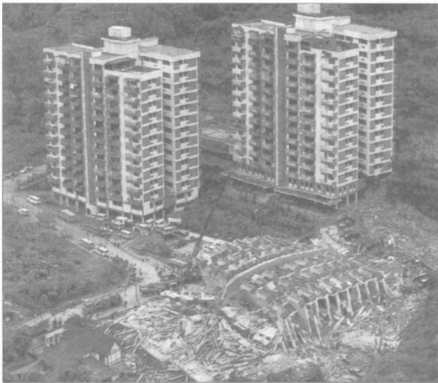
Obr. 1 – Pohled na komplex budov po zřícení objektu
