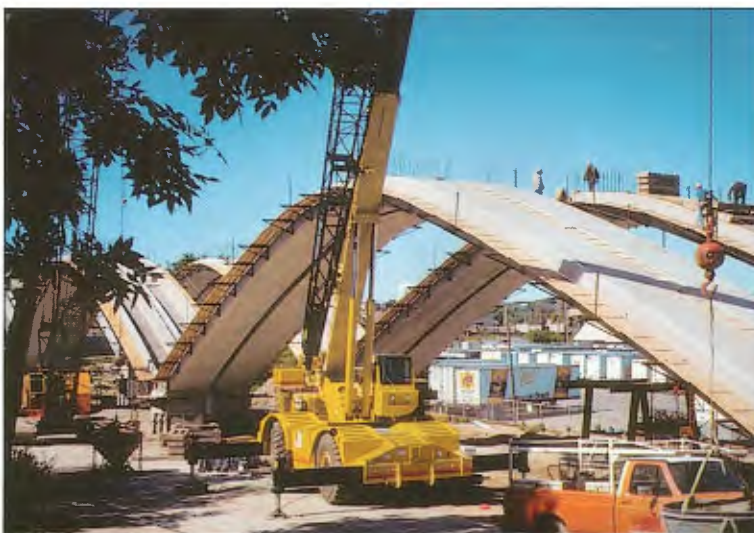
Obr. 22 – Betonáž monolitické části oblouku v 8. poli
