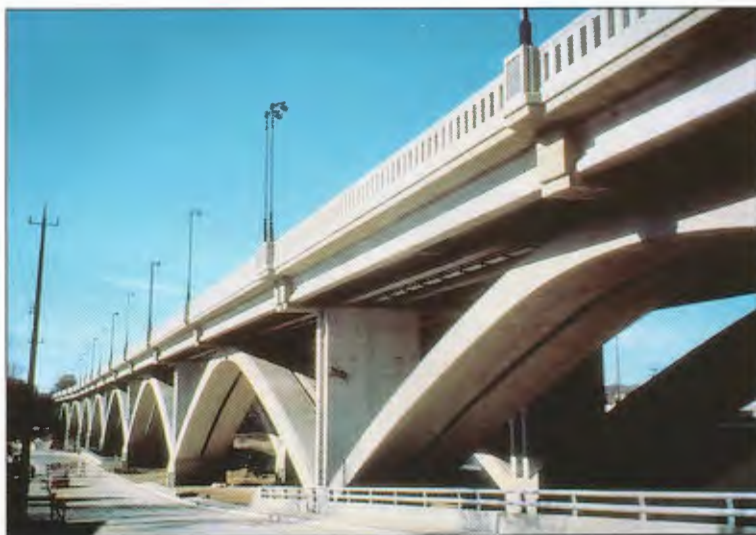
Obr. 36 – Pohled na dokončenou konstrukci
