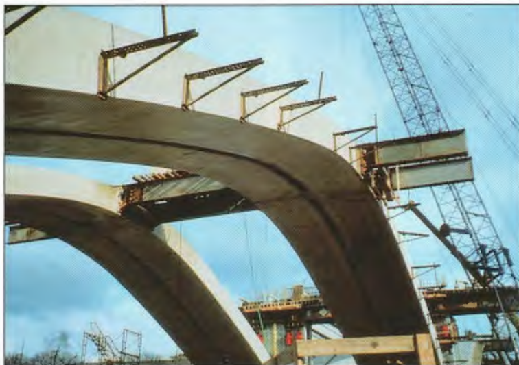
Obr. 33 – Konstrukce před montáží prefabrikovaných nosníků
