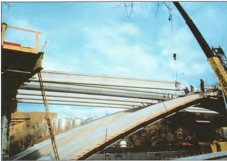
Obr. 23 – Montáž prefabrikovaných nosníků
