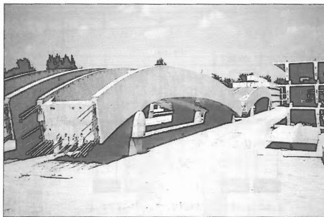
Obr. 15 – Obloukové segmenty typického pole – uložení na skládce
