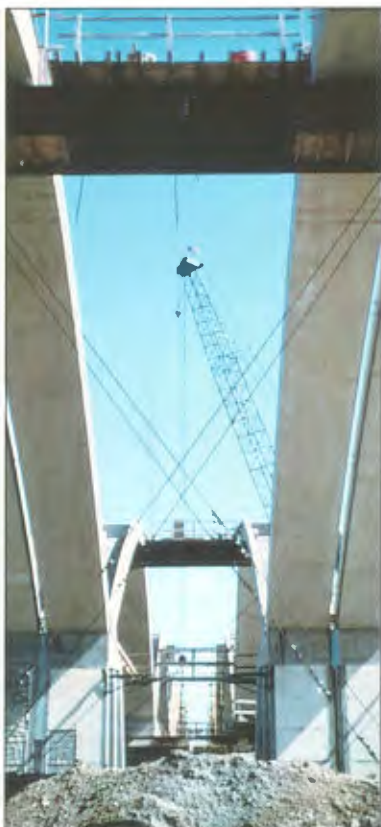
Obr. 30 – Prefabrikované obloukové segmenty 3. pole
