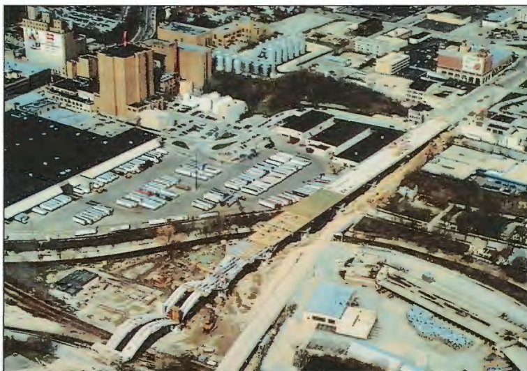
Obr. 18 – Postupná výstavba mostu
