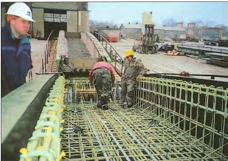
Obr. 29 – Betonáž prefabrikovaného obloukového segmentu
