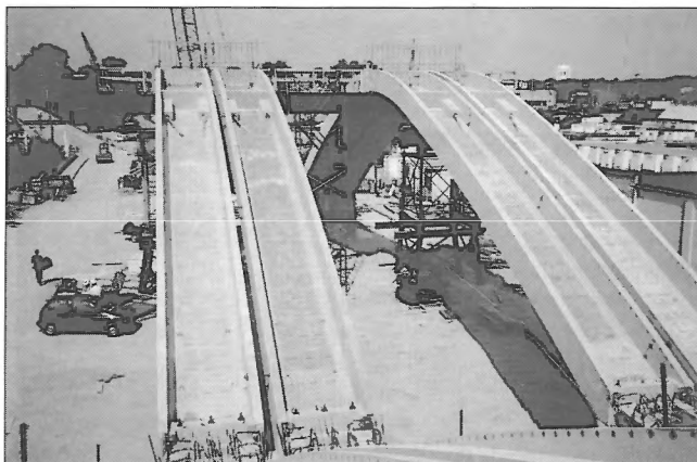
Obr. 11 – Obloukové segmenty typického pole (podélný pohled)
