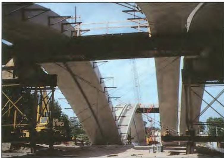
Obr. 21 – Prefabrikované obloukové segmenty 9. pole
