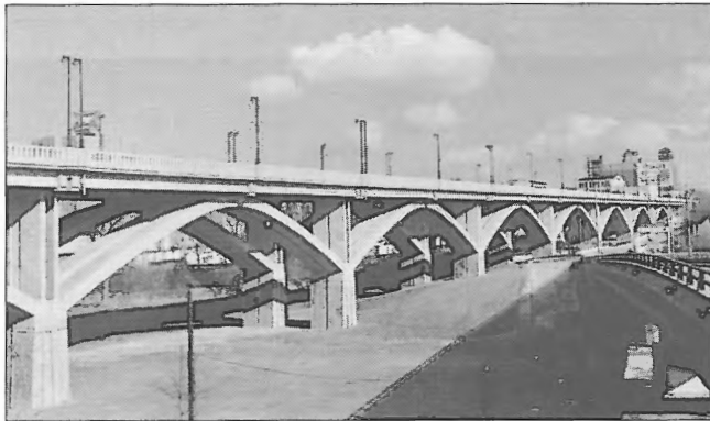
Obr. 5 – Nový most – pohled na dokončenou konstrukci
