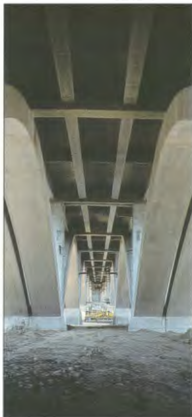
Obr. 35 – Konstrukce před dokončením
