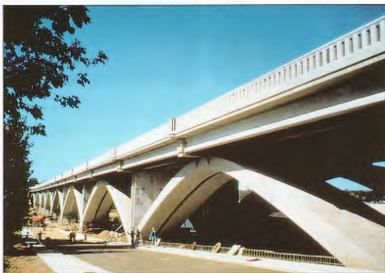
Obr. 34 – Konstrukce před dokončením
