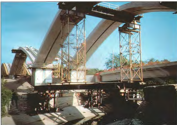
Obr. 31 – Prefabrikované obloukové segmenty 6. pole
