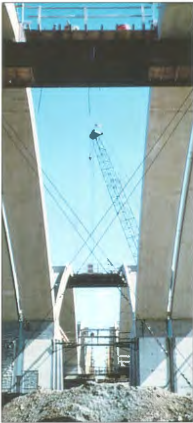
Obr. 30 – Prefabrikované obloukové segmenty 3. pole
