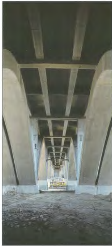
Obr. 35 – Konstrukce před dokončením
