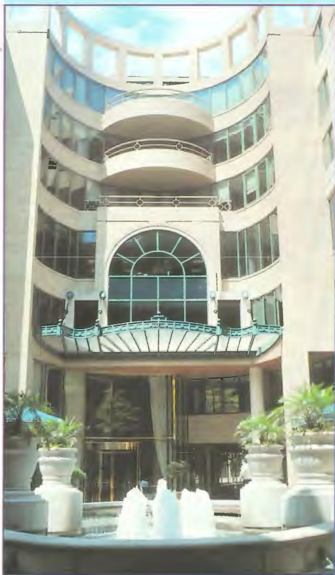
Obr. 10 - Washington Harbour monolitická konstrukce obložená prefabrikovanými dílci
