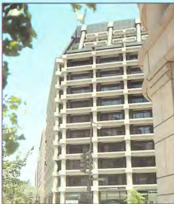
Obr. 4 - Administrativní budova ve Washingtonu s přiznaným prefabrikovaným skeletem
