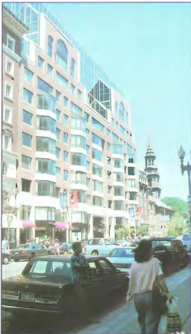
Obr. 11 - Boston - betonové dílece obvodového pláště nahrazují dražší kamenný obklad
