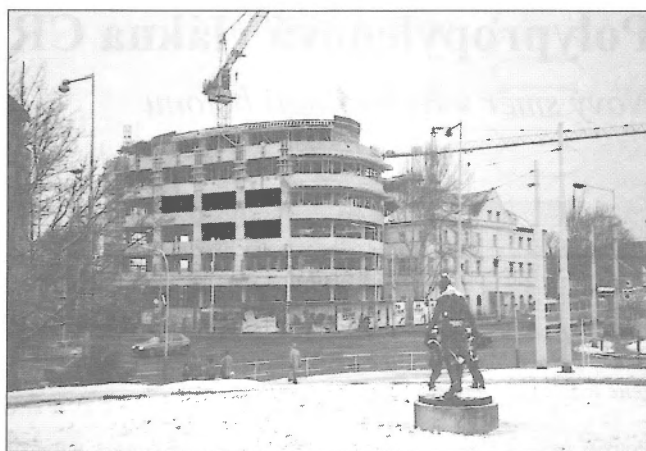
Obr. 4 – Dokončená hrubá železobetonová konstrukce
