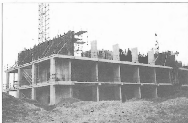
Obr. 3 – Pohled na rozestavěnou nadzemní část nosné konstrukce
