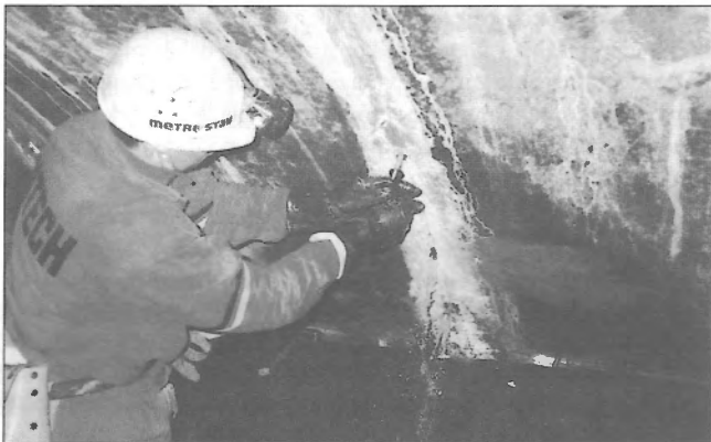
Obr. 5 – Osazování injektážní trubičky (packeru) do předvrtaného otvoru
