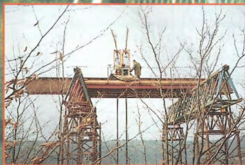
Obr. 27 - Tažení kabelů předpinacími pistolemi
