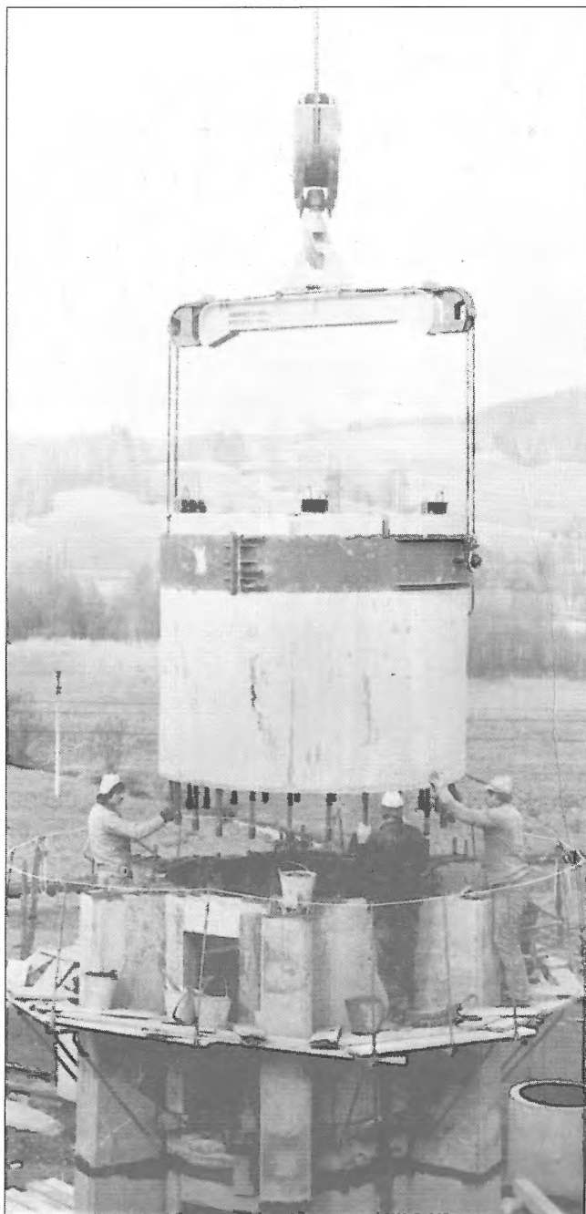
Obr. 3 – Osazování válcové části sekce
