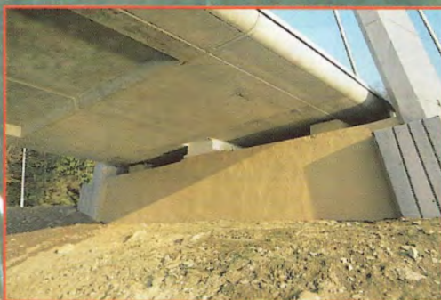
Obr. 21 - Uložení mostovky na pylonu
