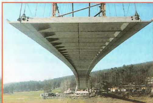
Obr. 15 - Mostovka - prefabrikovaný segment zavěšený na visutých kabelech
