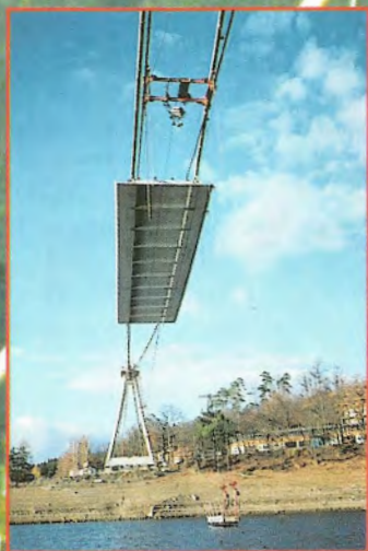
Obr. 32 - Konstrukce po montáži středních segmentů
