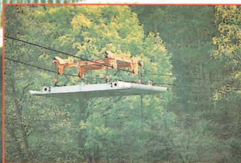
Obr. 30 - Posun segmentů po montážních kabelech
