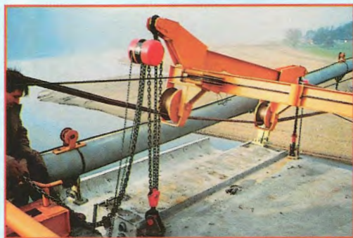
Obr. 31 - Zavěšení segmentů na visuté kabely
