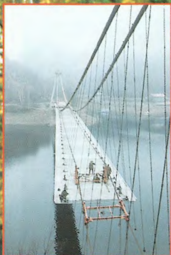
Obr. 34 - Konstrukce před montáží středních segmentů
