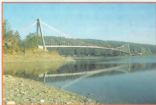
Obr. 1 - Pohled na lávku
