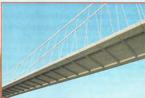
Obr. 16 - Mostovka - pohled na smontovanou konstrukci
