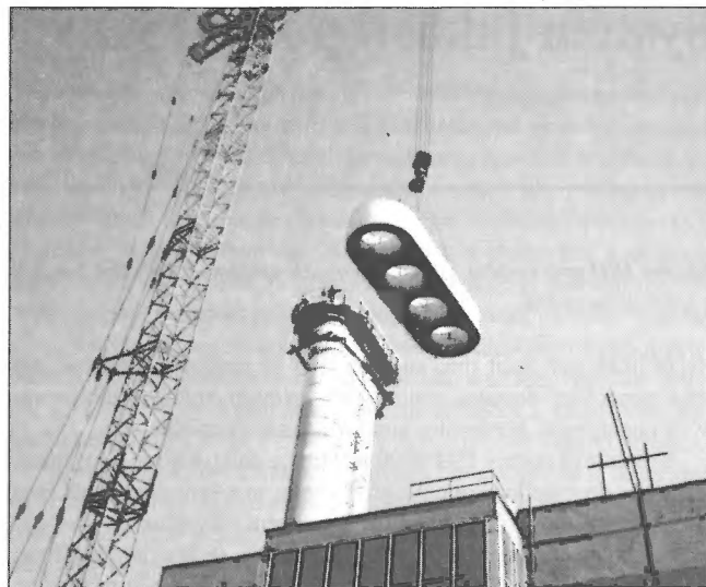
Obr. 5 – Osazování sekce nekruhového průřezu
