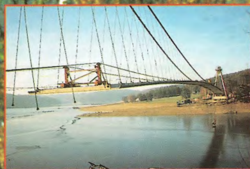
Obr. 36 - Konstrukce před montáží středních segmentů
