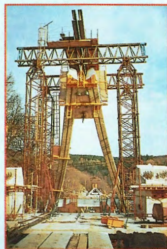
Obr. 26 - Vyzdvižení pylonu pomocí montážních věží
