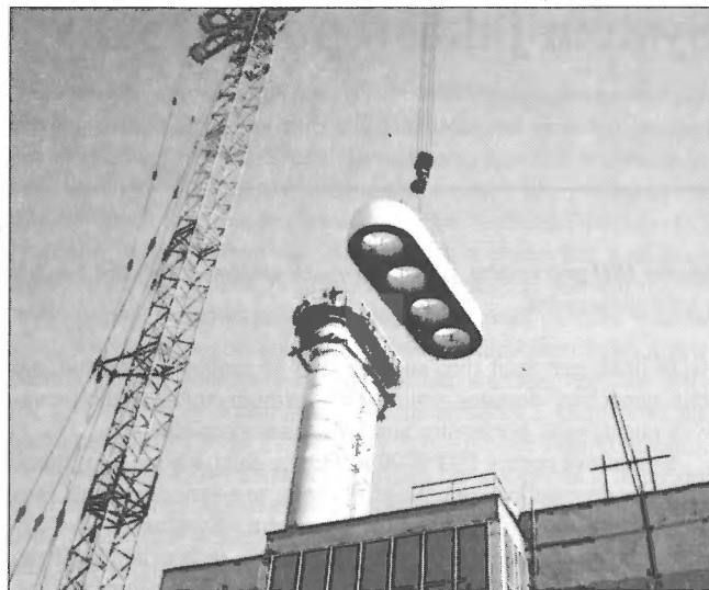
Obr. 5 – Osazování sekce nekruhového průřezu
