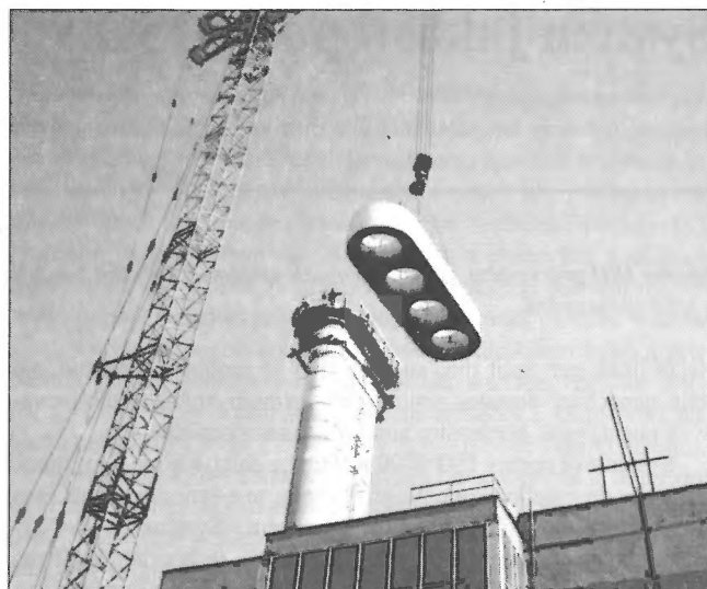
Obr. 5 – Osazování sekce nekruhového průřezu
