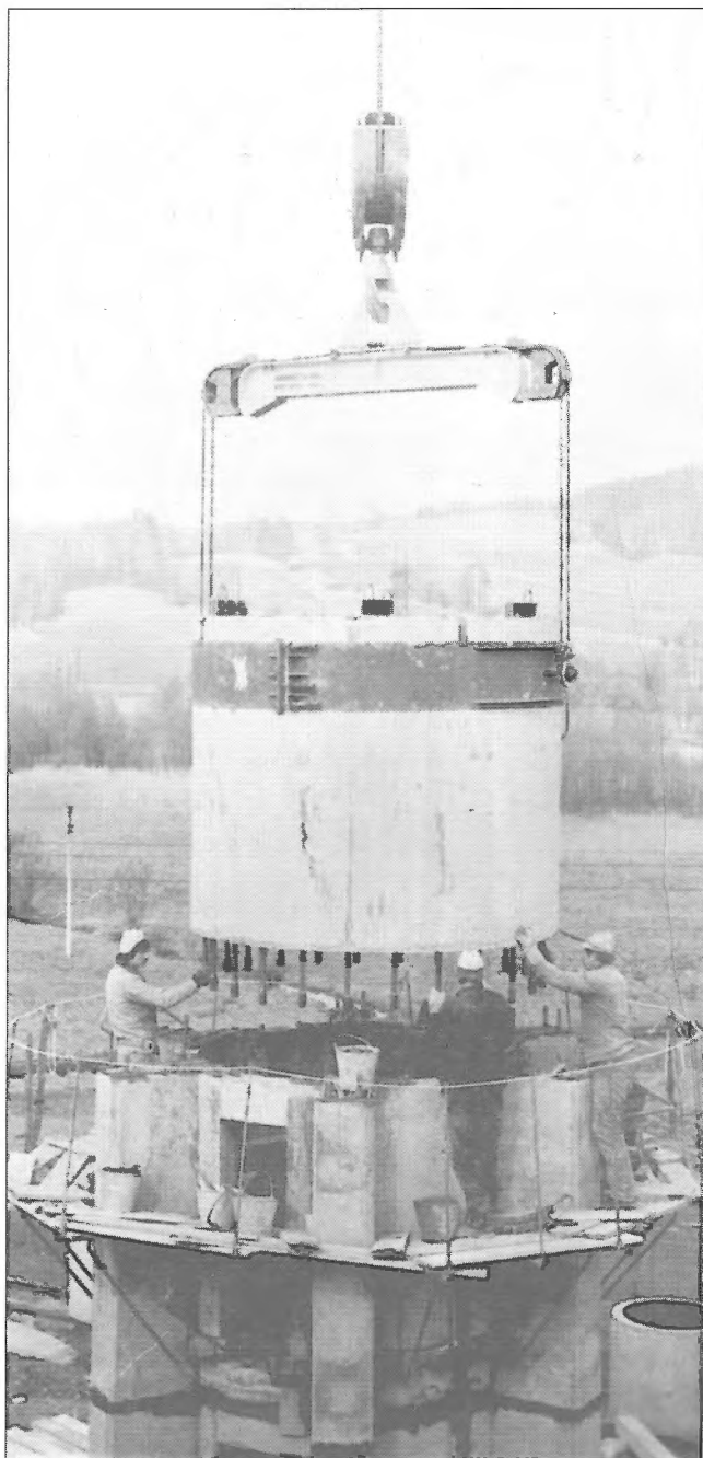
Obr. 3 – Osazování válcové části sekce
