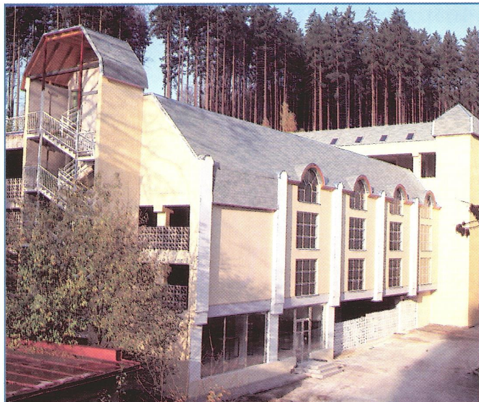
Parking centrum Mariánské Lázně - průběžné sloupy na čtyři podlaží, nosníky s konzolami a žebrové stropní panely TT ukládané deskou. Realizace 1993.
