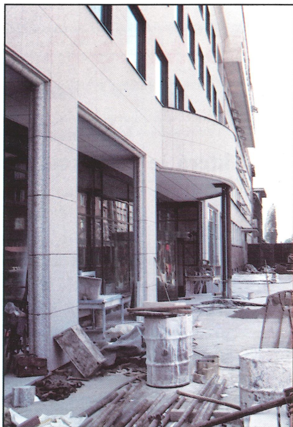
Konečná úprava plochých pilířů obvodového pláště
