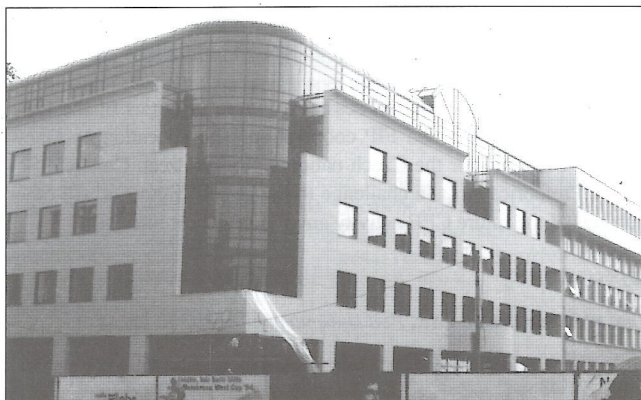
Obr. 1 – Česká pojišťovna před dokončením
