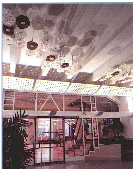
Agrobanka a Dům techniky v proluce historického jádra Pardubic. Sloupy a nosníky tvaru "U" pro vedení skrytých rozvodů, žebrové panely s konzolami. Realizace 1992.
