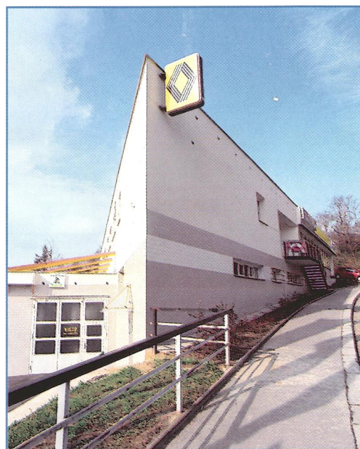
Parking centrum Mariánské Lázně - průběžné sloupy na čtyři podlaží, nosníky s konzolami a žebrové stropní panely TT ukládané deskou. Realizace 1993.
