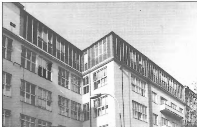
Obr. 12 – Pohled na nástavbu po ukončení výstavby
