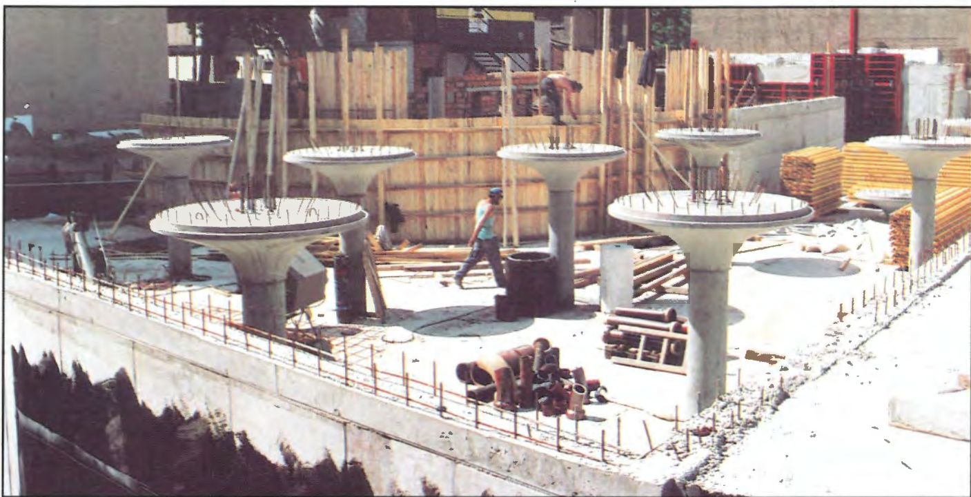
Sloupy suterénu provozní budovy
