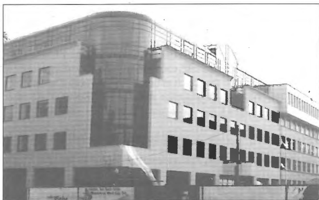
Obr. 1 – Česká pojišťovna před dokončením
