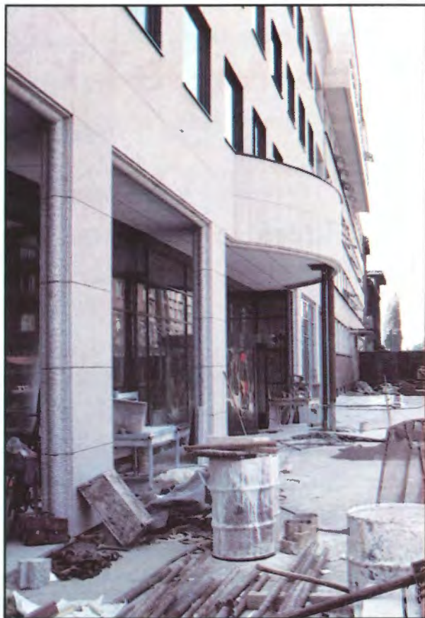
Konečná úprava plochých pilířů obvodového pláště
