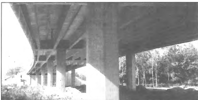
Obr. 3 – Pohled mostní konstrukce
