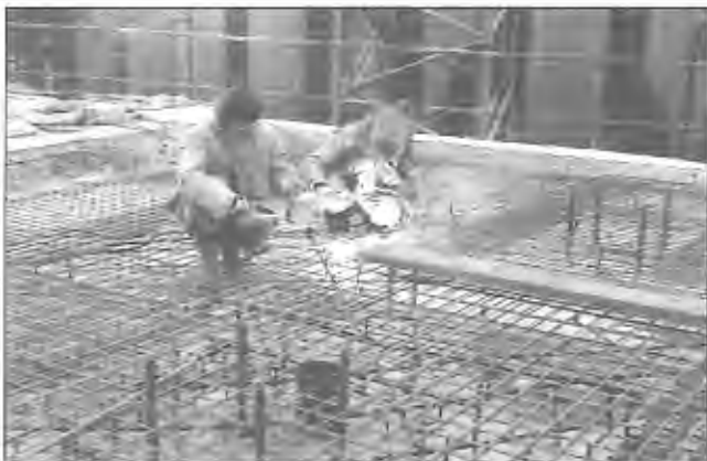
Obr. 4 – Vyztužení desky v oblasti sloupu a hlavice
