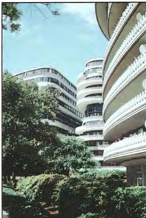
OBYTŇNÝ KOMPLEX WATERGATE
