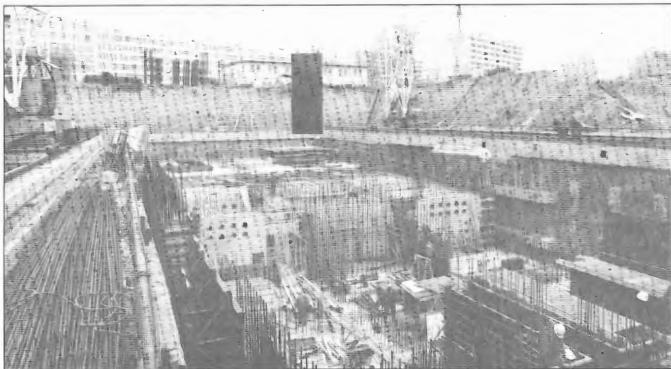
Obr. 3 - Stavební jáma a výstavba základové skříně
