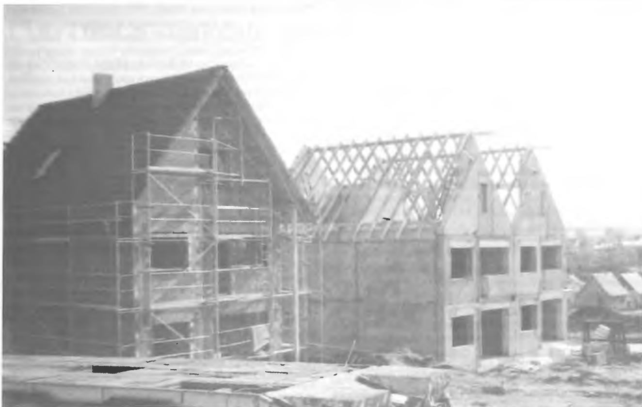
Obr. 1 - Prefabrikáty z LIAPORu u bytové výstavby
