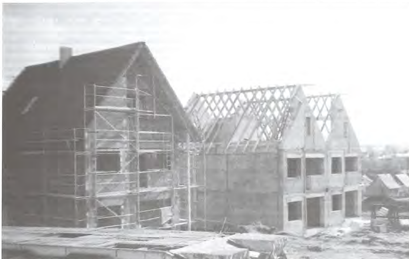
Obr. 1 - Prefabrikáty z LIAPORu u bytové výstavby
