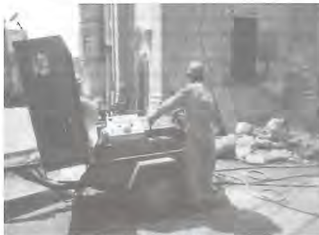
Obr. 5 - Sanace vlhkého zdiva na kostele Sv. Jana v Nepomuku - Ustavení lanové pily
