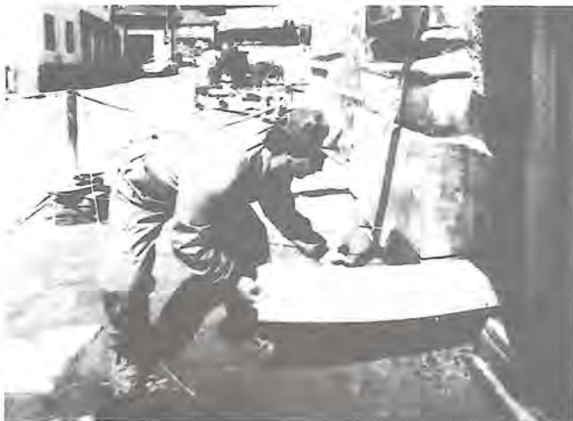
Obr. 6 - Sanace vlhkého zdiva na kostele Sv. Jana v Nepomuku - Vkládání izolace
