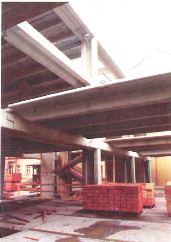
Obr.2 Detail konstrukce se základními nosnými prvky
