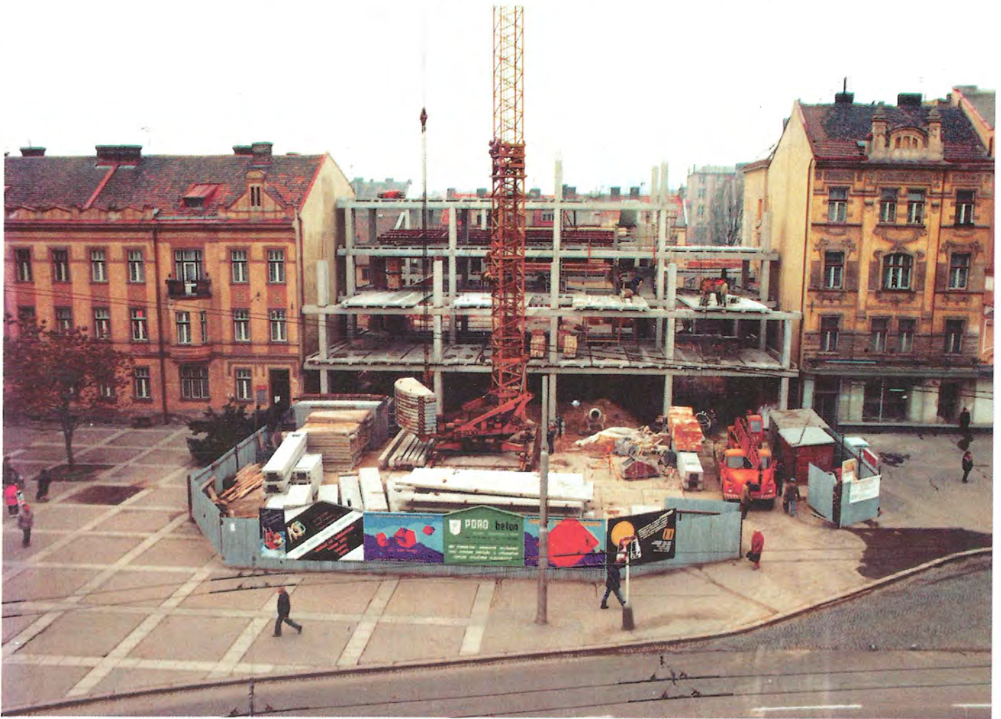
Obr.1 Celkový pohled na konstrukci při montáži
