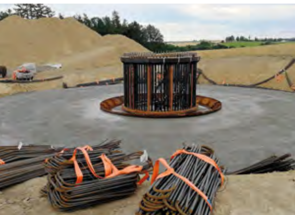
1 Betonáž základu s instalací nosného prstence 2 Provádění betonáže betonem C30/37 - XA1 - D max 16 - S4 3 Betonáž nosného prstence tubusu elektrárny betonem C45/55 - XF3 4 Odečítání teplot pomocí senzoru Giatec 360 bezdrátově pomocí aplikace v mobilním telefonu
